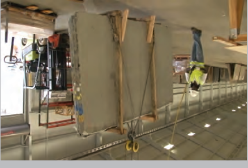
Manejo de múltiples losas en un cabestrillo
