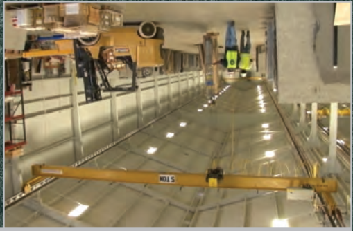
Visión ampliada de la grúa
