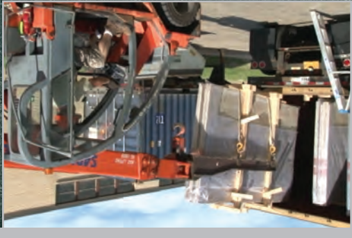
Grúa móvil extraer un conjunto de losas de un contenedor en un patio exterior de piedra
