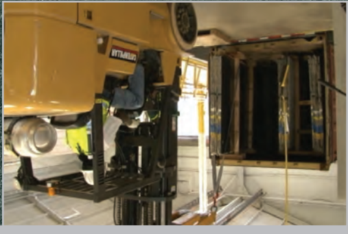
Montacarga de losas contenedor cubrir
