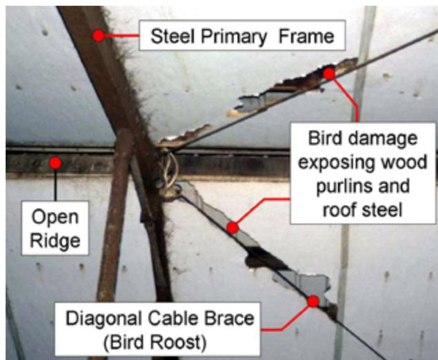
FIGURE 5. BIRD DAMAGE.
